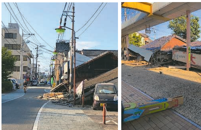
八代市内の通町商店街振興組合、本町3丁目商店街振興組合の被災状況(熊本県振連提供)
